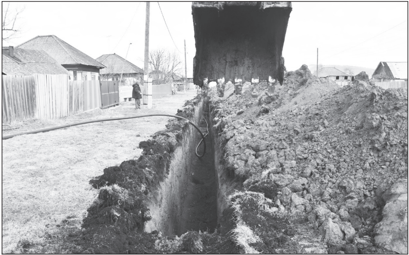
1,5 млн. руб. потрачено на ремонт водопроводных сетей в населённых пунктах района
